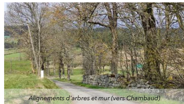
Mur et bâti traditionnel au hameau de Bessous
