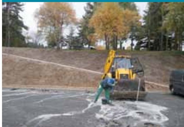
Anthony lors de la pose du terrain multisports
