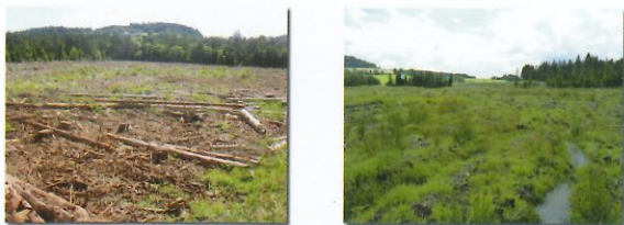
Zone humide : avant et après travaux
